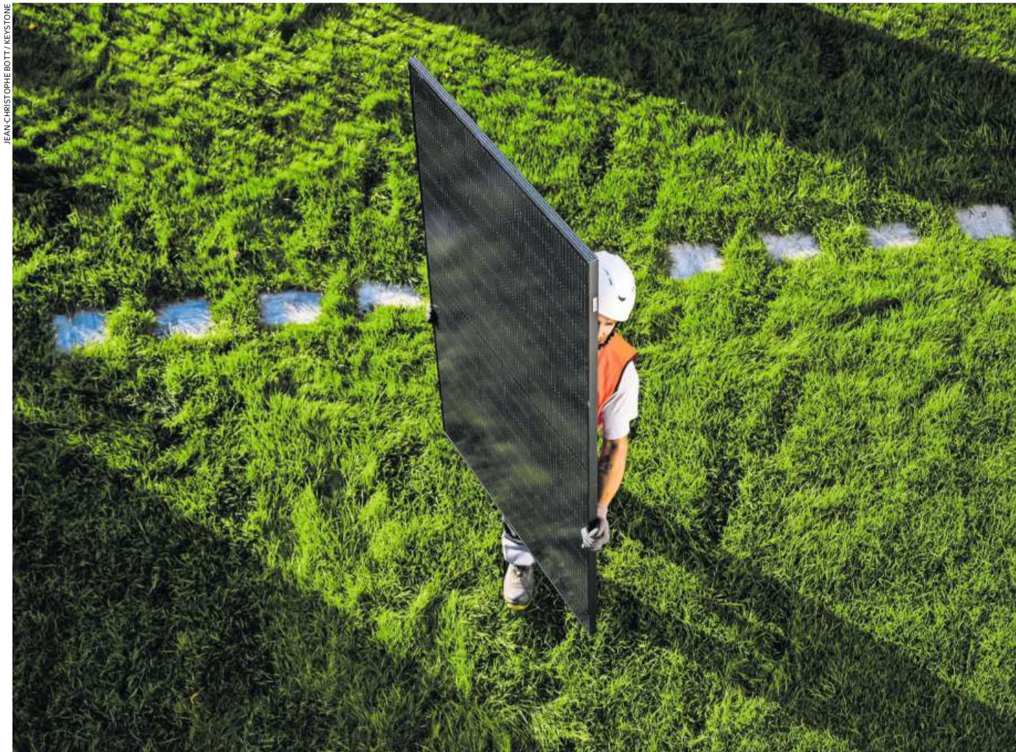
Ein Installateur trägt ein Solarpanel durch einen Hausgarten.
